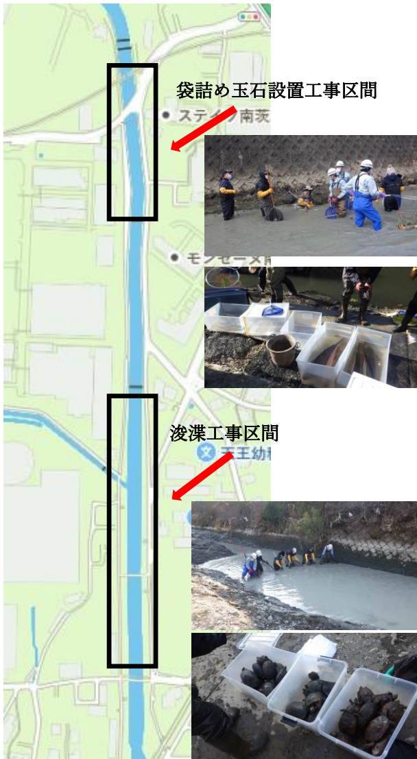
大正川の袋詰め玉石設置工事・浚渫工事区間
